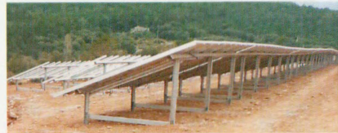
↗ Ancrage par pieux vibrofoncés
