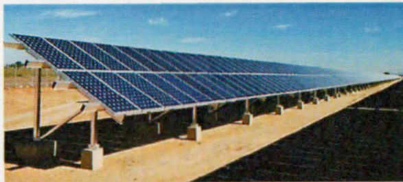
↗ Ancrage par plots bétons
